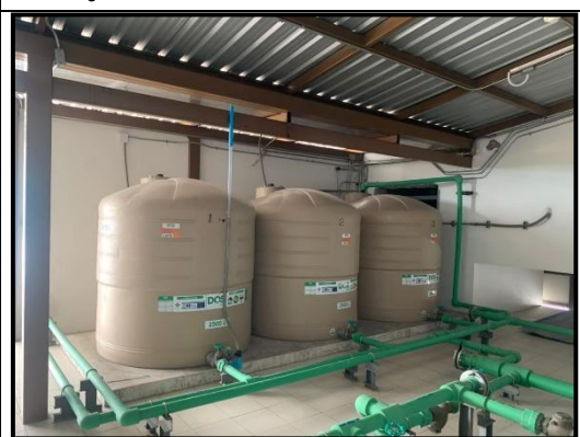
รูปที่ 42 ถังเก็บน้ำดีชั้นดาดฟ้า
